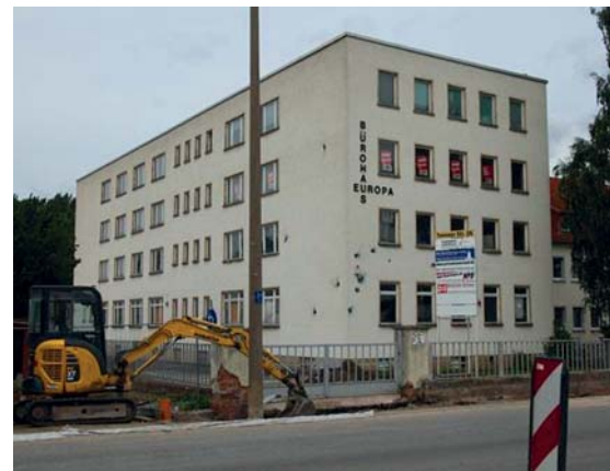
Das „Europa“-Bürohaus in Bad Langensalza wird angeblich von NPD-Gliederungen und -Firmen genutzt.
